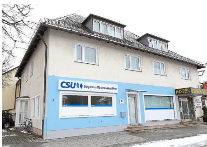
Hier in der Verdistrasse 135 hat Josef Schmid nun auch sein Abgeordnetenbüro, zusammen mit dem Bundestagskollegen Stephan Pilsinger.
